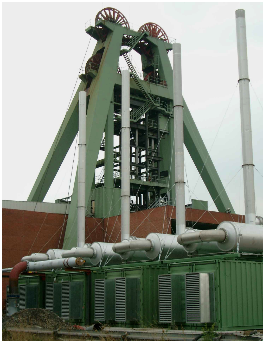
Abb. 1: BHKW auf aktiver Schachthanlage
